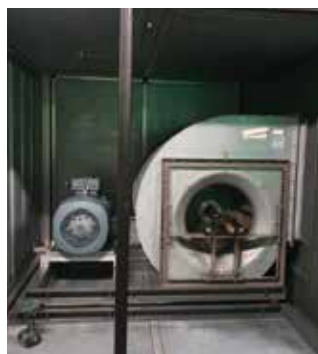
Eine der grossen Umluft-Ventilatoren vor und nach der Erneuerung. Fotos: Lufttechnik AG Wädenswil.
