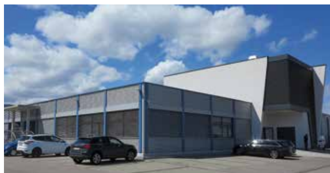
Bâtiment de l'usine Décovi SA. Photo: Márton Varga, Topmotors
