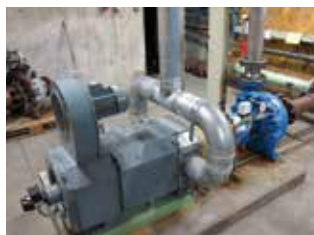
A sinistra: la vecchia pompa con motore a corrente continua, raffreddamento e aspirazione. A destra: la nuova pompa in un unico alloggiamento. Foto: Topmotors
