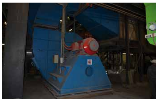
Ventilateur d'air primaire centrifuge, 95 000 m 3 /h, surpression \Delta p de 55 mbar
