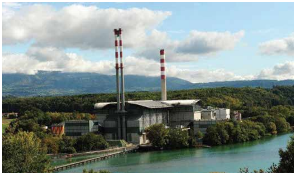
Situation de l'usine d'incinération sur le Rhône à l'extérieur de Genève
