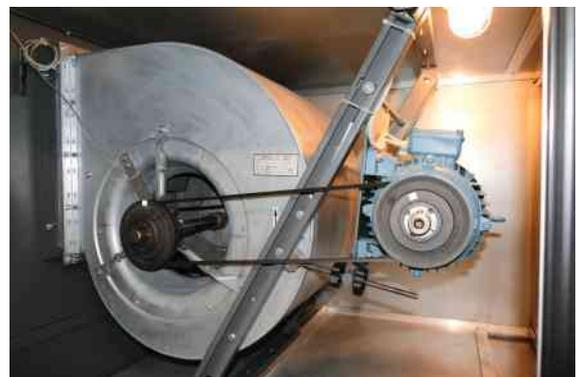
Im Bild ein Motor im Anwendungsbereich Lüftung/Ventilatoren.
