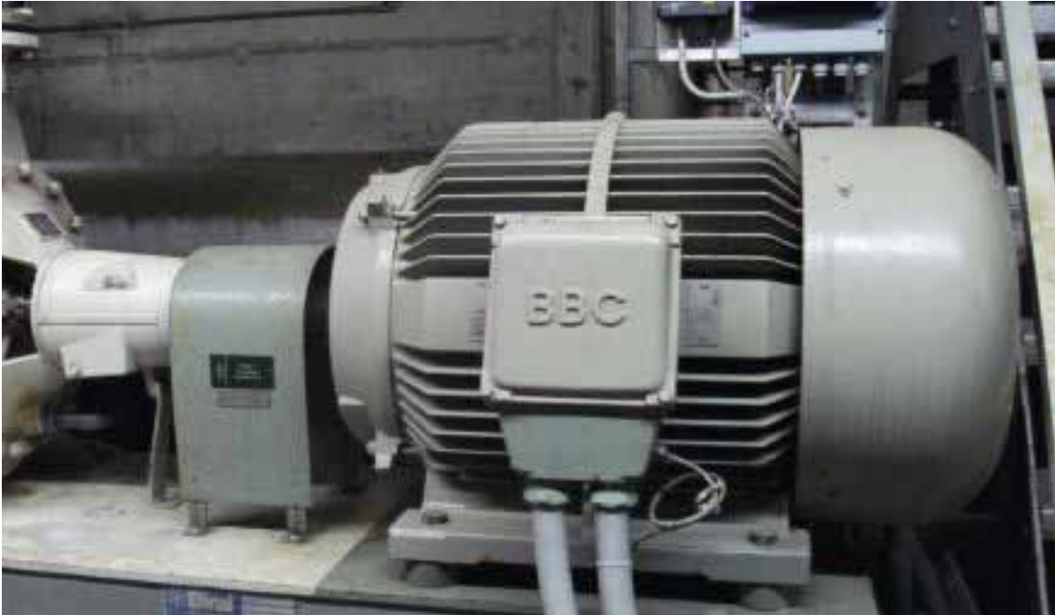
1988 fusionierte BBC mit Asea zu ABB – der Motor läuft 24 Jahre später immer noch. Das spricht zwar für dessen Dauerhaftigkeit, aber nicht unbedingt für seine Energieeffizienz. (Bild: Programm Easy)
