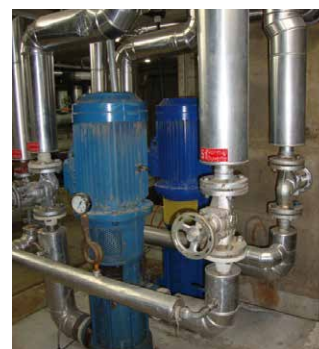
Links: Zustand vor dem Umbau mit 12,5-kW-Motoren Rechts: Zustand nach dem Umbau mit 7,5-kW-Motoren
