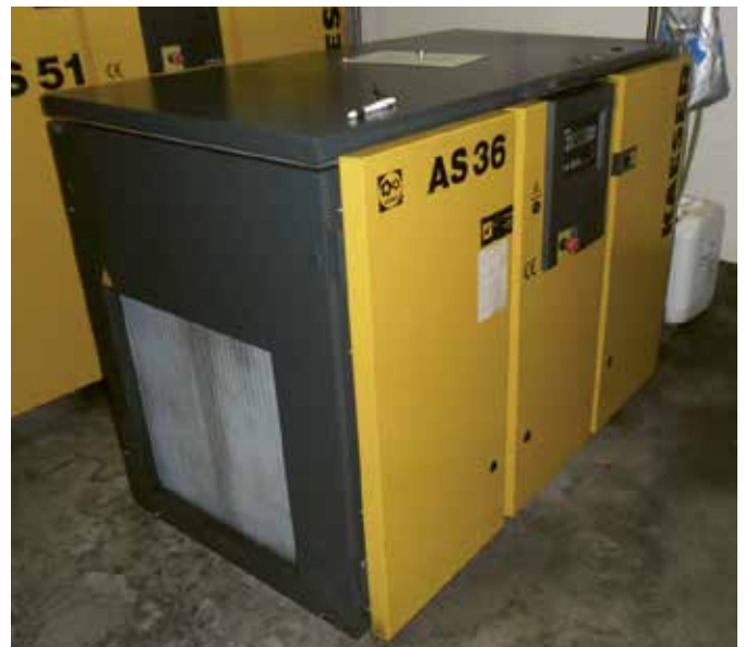
Akustisch gekapselter Kältekompressor
